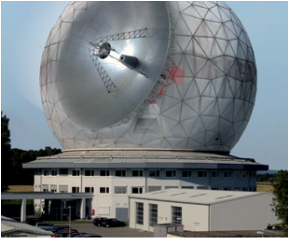
Die Fraunhofer-Gesellschaft analysiert mit dem Weltraumbeobachtungsradar TIRA Raumfahrtrückstände und andere Weltraumobjekte und trägt damit zur Sicherheit im Weltraum bei.
