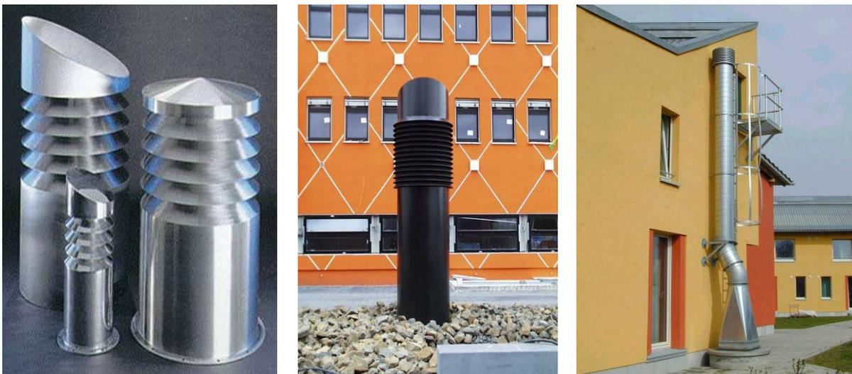
**Bild 35** Beispiele Lamellenhaube und Ansaugröhre des L-EWT des Studentenwohnheims der FH-Aachen (rechts)
