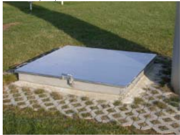
Bild 1.39 Neue Schachtabdeckung oberhalb der Geländekante
