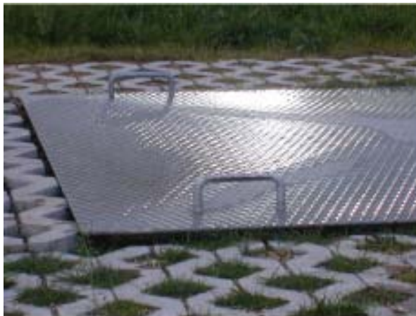
Bild 1.36 Schachtabdeckung unterhalb der Geländekante
