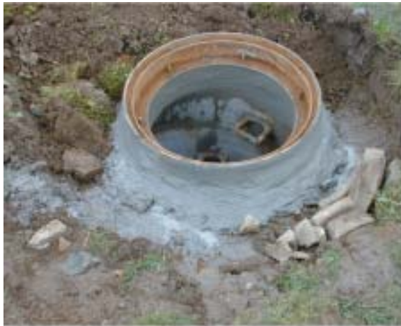
Bild 1.346 Abdichtmaßnahme des zweiten Revisionschachtes
