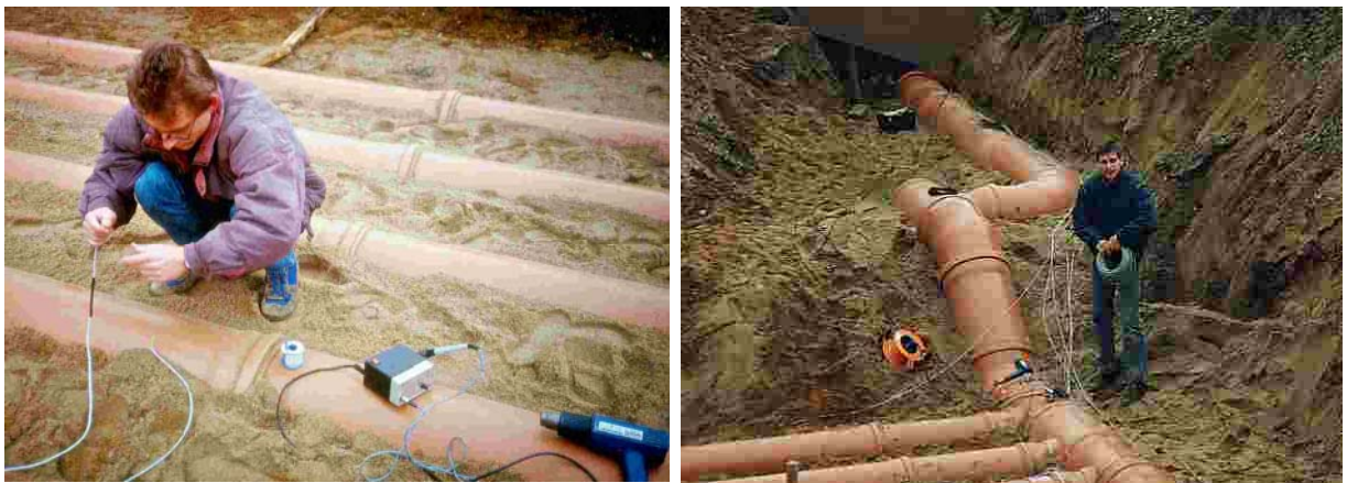
Bild 2.18 Aufwändige Installation der Messtechnik
