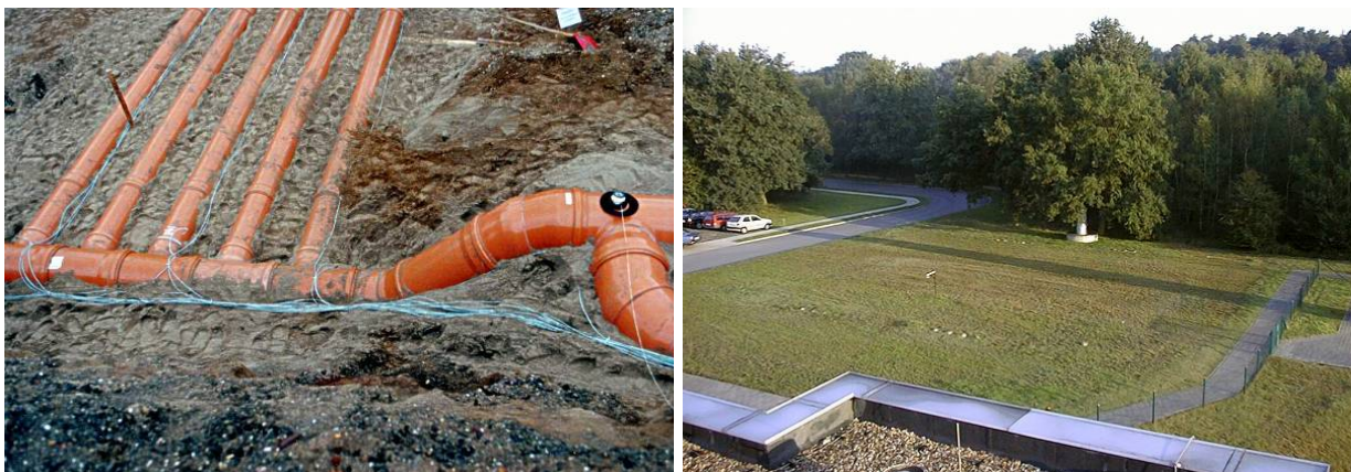
Bild 2.19 Vor und nach dem Schließen der Baugrube
