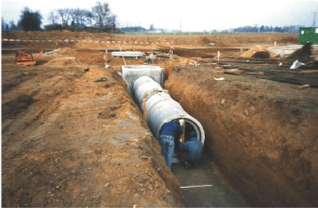
Bild 1.2 Luft-Erdwärmetauscher Auditorium im Bau
