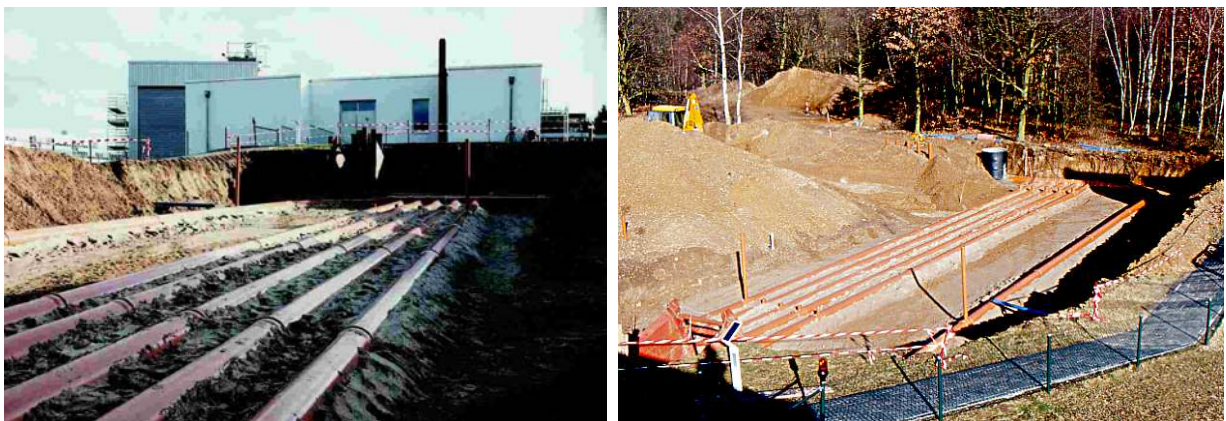
Bild 2.16 flache Verlegetiefe in 1,5 m
