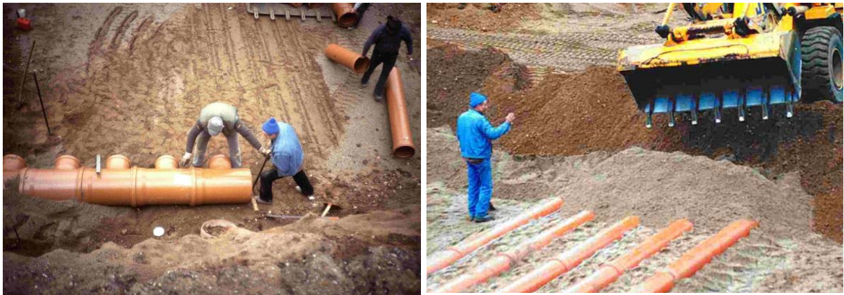
Bild 2.17 Zusammenbau des Sammelkanals und Verdichten des rohrnahen Bereichs mit Feinkies
