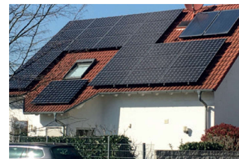
Bei der automatisierten Detektion von Solaranlagen muss die Software verschiedene Elemente unterscheiden können, um Fehlklassifikationen zu vermeiden. Solche Dächer dienen zu Testzwecken. Hier sind sowohl Solarthermie- als auch Photovoltaikmodule zu sehen, aber auch ein Dachfenster, das nicht fälschlicherweise als Solaranlage gekennzeichnet werden darf.
