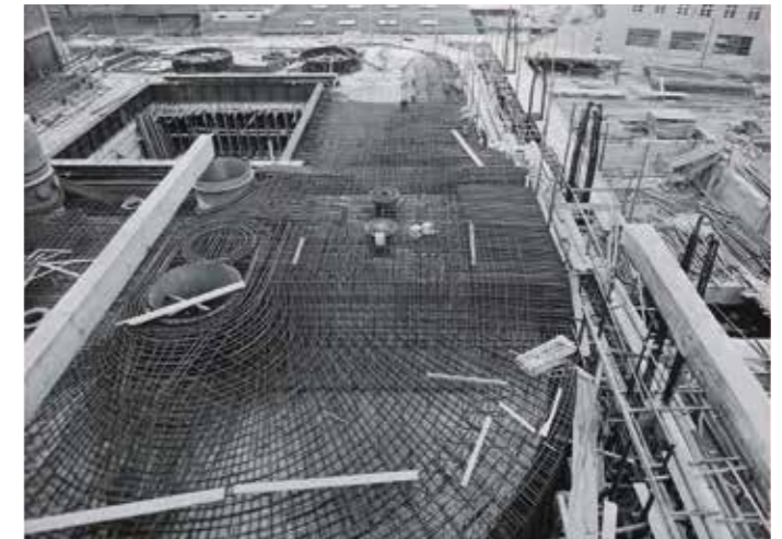
Großbaustelle für den weltweit ersten Kryokanal: Der GR II im Bau 1941
