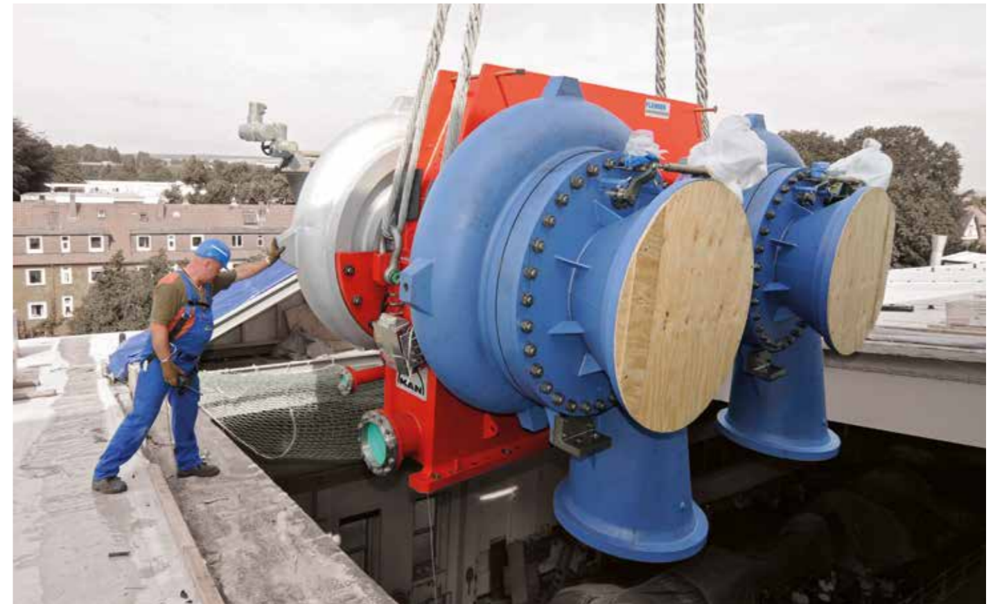
Beim Bau des neuen Turbinenprüfstands NG-Turb im DLR Göttingen: Der 77 Tonnen schwere Verdichter wurde durch das offene Dach eingesetzt
