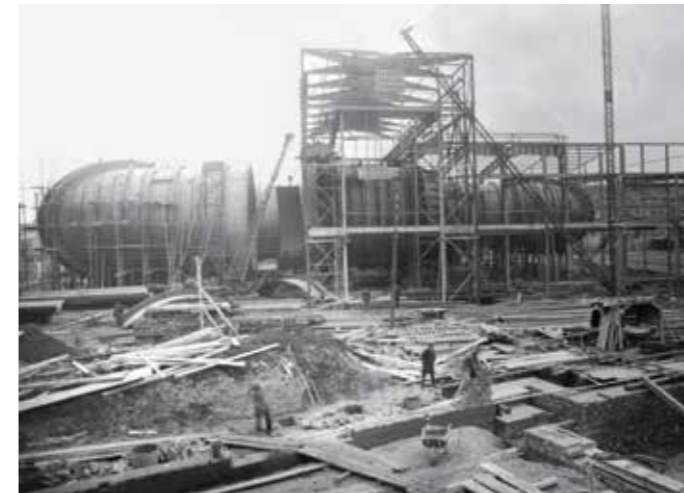
Bau des Göttinger Windkanals 6 im Jahr 1935: Man sieht die Montage der Kanalrohre und die Stahlkonstruktion für das den Kanal umgebende Gebäude
