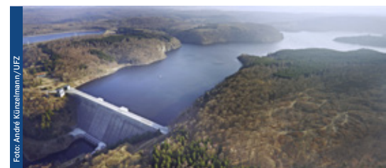
Versorgt Region mit Trinkwasser: Rappbode-Talsperre
