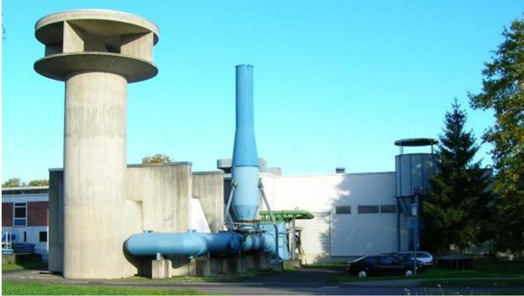
Das DLR betreibt in Köln einen großen Mehrwellen-Verdichter-Prüfstand mit idealen Voraussetzungen für die Untersuchung von hocheffizienten mehrwelligen Hochdruckverdichter-Konfigurationen.
