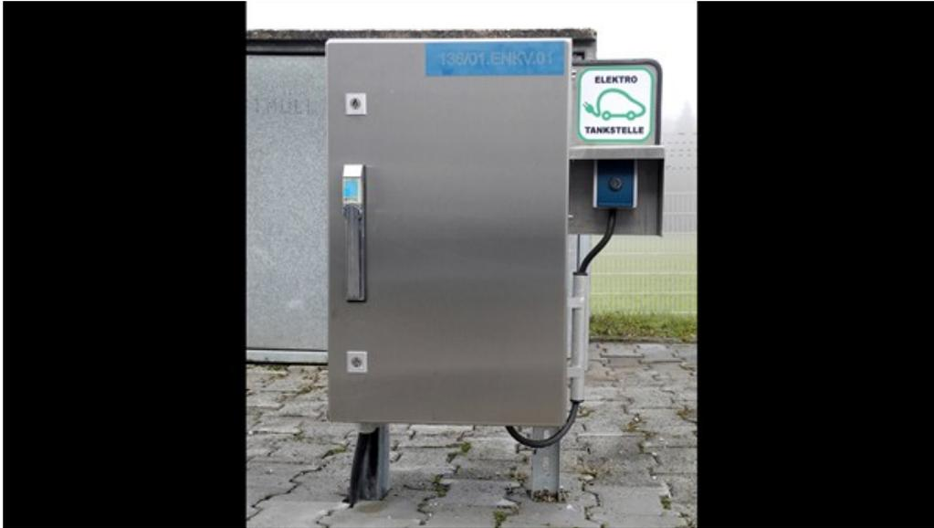
Eine Norm für E-Tankstellen gibt es bisher nicht. Die Parkplatzbereiche in Weilheim wurden zunächst mit Stromanschlüssen ausgestattet. Für den Einstieg hat das DLR eine Ladestation installiert, die aus einer einfachen Haushaltssteckdose mit Stromzähler besteht und nach Bedarf erweitert werden kann.
