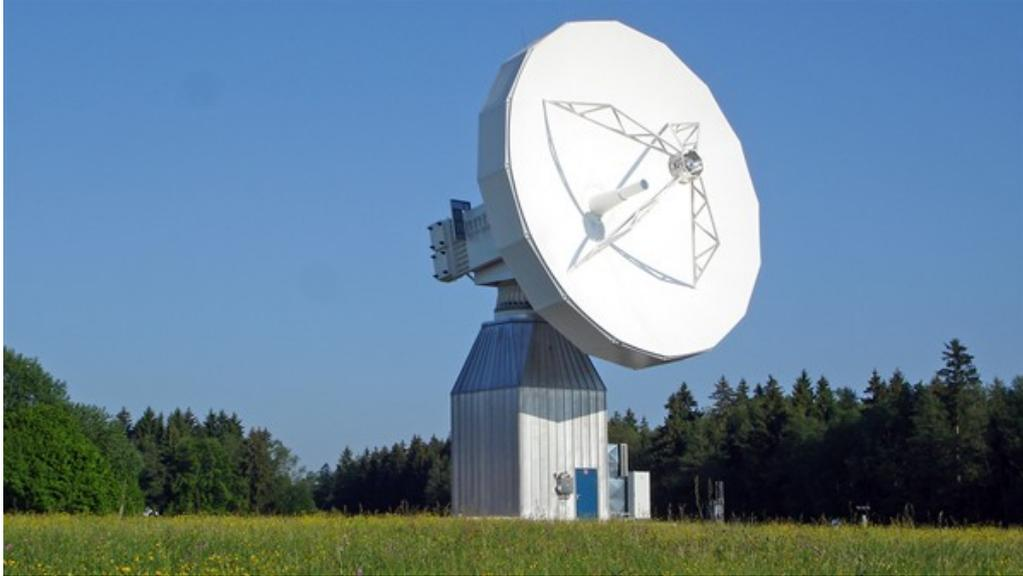
Größer, stärker und genauer - die neue Antenne in Weilheim schafft neue Dimensionen. Sie verfügt über einen Reflektor mit stolzen 13 Meter Durchmesser und deckt im sogenannten Ka-Band einen Frequenzbereich zwischen 18,1 und 30 Gigahertz ab. Mit 91 Dezibel Watt ist ihre Ausgangsleistung sprichwörtlich spitze.
