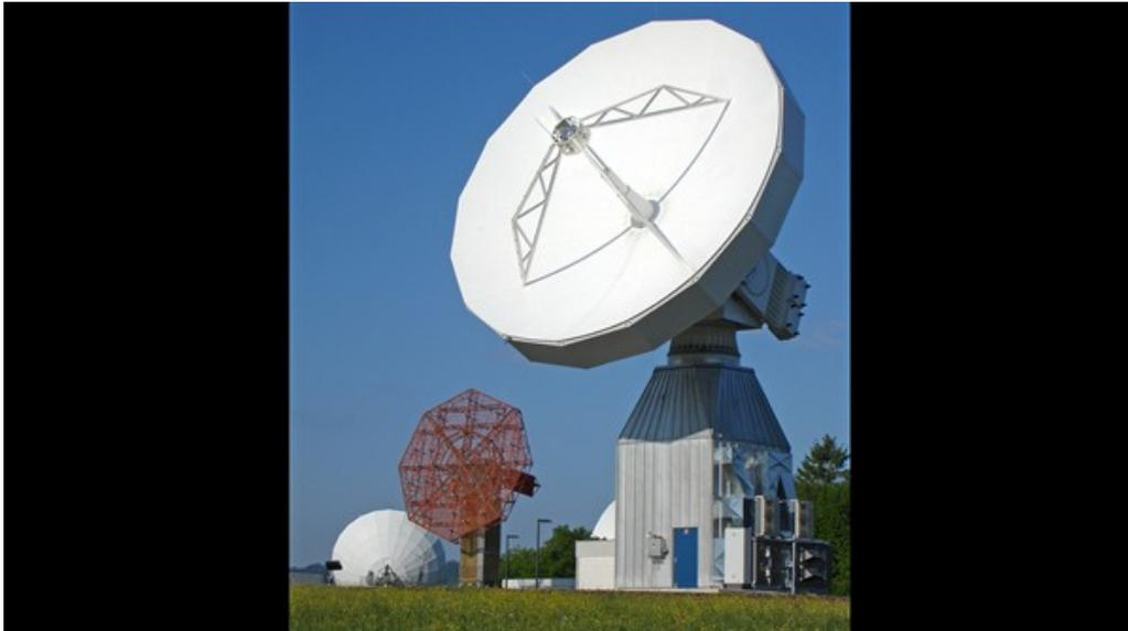
Als Tor in die neue Dimension muss die 13-Meter-Antenne höchste Anforderungen in der Herstellungsgenauigkeit und der Bewegungspräzision erfüllen. So ist ihr Parabolspiegel auf ein Zehntel Millimeter genau gefertigt und trotz dabei allen saisonalen Außentemperaturen. Die Richtgenauigkeit der Empfangsanlage beträgt  $0,001^\circ$ .
