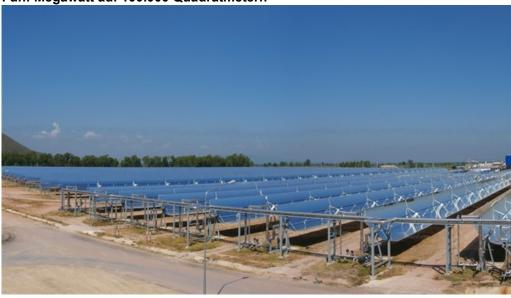
Das Sonnenwärmekraftwerk in der thailändischen Provinz Kanchanaburi steht auf einem Areal von 100.000 Quadratmetern. Dort wurden 86 Kollektor-Rinnen mit einer Länge von je 120 Metern errichtet. Das Kraftwerk hat eine Leistung von fünf Megawatt. Mit der Planung und dem Bau der Anlage war die deutsche Firma Solarlite beauftragt.
