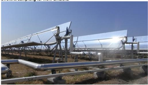
Das Kraftwerk ist das erste Parabolrinnen-Kraftwerk, bei dem der Dampf zum Antrieb einer Turbine direkt in den Parabolrinnen erzeugt wird. Langfristig sollen mit der solaren Direktverdampfung die Kosten von Sonnenwärmekraftwerken gesenkt werden.
