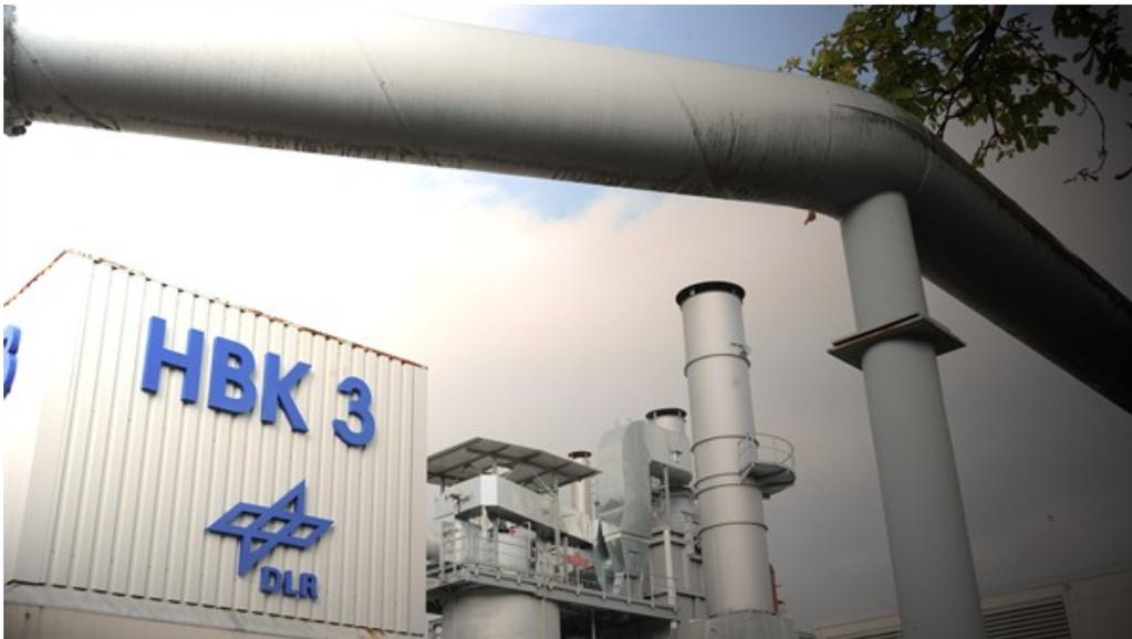
Der neue "LuVo3" versorgt die Prüfstände mit Luftmassenströmen von bis zu 70 Kilogramm pro Sekunde, die mit maximal 700 Grad Celsius in die zu testenden Brennkammern eingeleitet werden.
