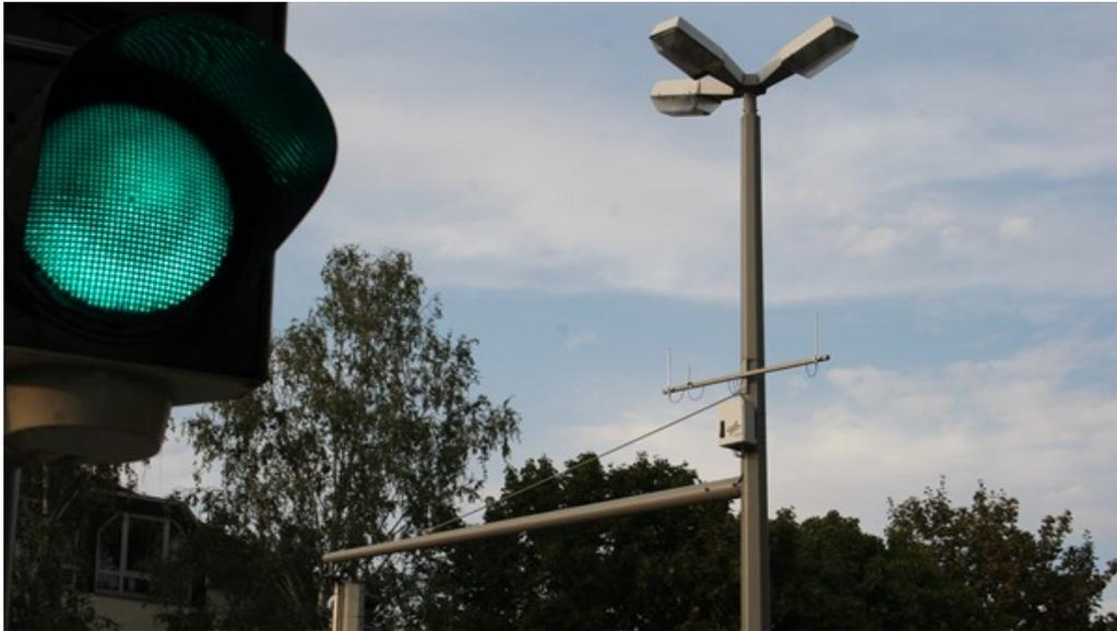
In einem ersten Schritt brachte das DLR an drei Ampelkreuzungen des Braunschweiger Rings Kommunikationseinheiten an.
