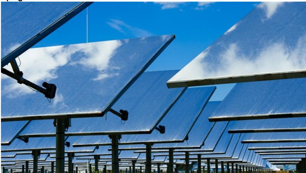
Auf einer Fläche von zirka acht Hektar stehen in Jülich 2153 bewegliche Spiegel (Heliostate) und lenken die Sonnenstrahlen auf die Spitze des 60 Meter hohen Turms.
