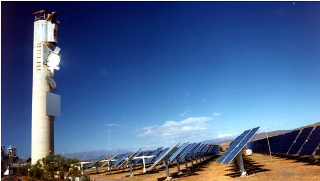
Standorte des neuen Instituts sind Köln, Jülich, Stuttgart und Almería. Im spanischen Almería forschen DLR-Wissenschaftler seit 30 Jahren an Solarkraftwerken. Das solare Turmkraftwerk auf der Plataforma Solar in Almería ist umgeben von einem Spiegelfeld, das die Solarstrahlung auf Strahlungsempfänger reflektiert. Mit der so gesammelten Wärmeenergie wird eine Turbine angetrieben, die Strom erzeugt.
