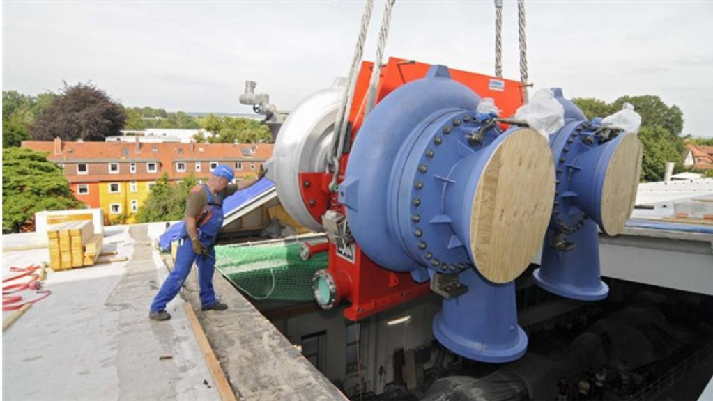
Der 77 Tonnen schwere Verdichter wurde durch ein geöffnetes Dach in ein Versuchsgebäude eingesetzt. Die Maschine soll künftig wie eine riesige Luftpumpe einen neuen Turbinenprüfstand antreiben, in dem an den Turbinen für die Flugzeuge und Kraftwerke der Zukunft geforscht wird.
