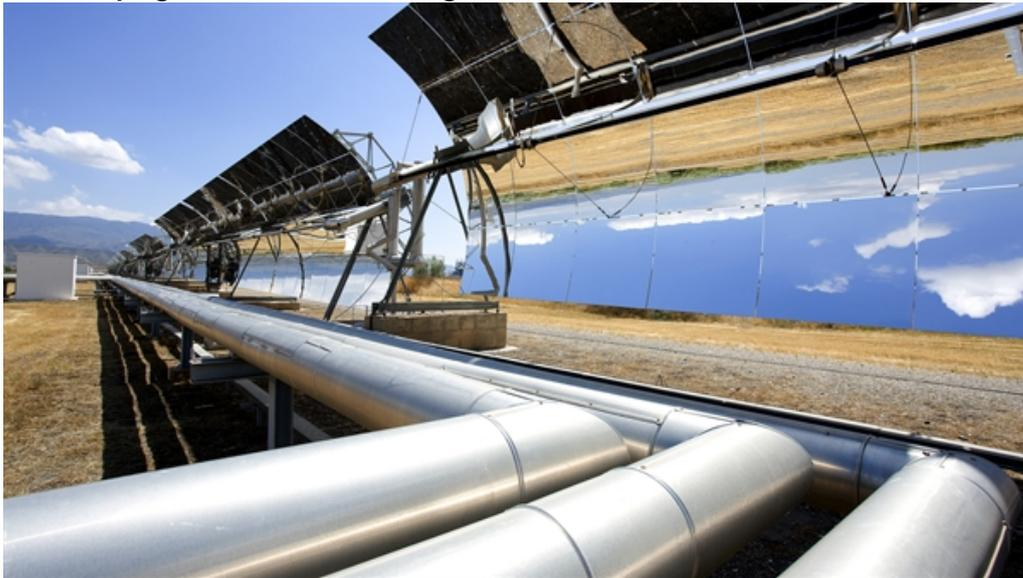
Parabolspiegel einer Versuchsanlage auf der Plataforma Solar in Almeria/Spanien. Das Deutsche Zentrum für Luft- und Raumfahrt (DLR) testet und optimiert auf dem über 100 Hektar großen Gelände verschiedene Hochtemperatur-Solartechnologien unter praxisnahen Bedingungen.
