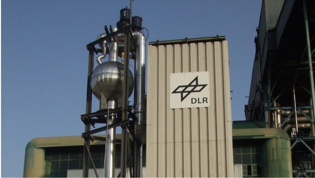
Der Hochtemperatur-Latentwärmespeicher ist ein mit Salz gefüllter Phasenwechselfpeicher. Bei 305 Grad Celsius nimmt das Salz Energie dadurch auf, dass es von einem festen in einen flüssigen Zustand übergeht. Latente Wärme ist "verborgene" Energie, die Wasser zum Beispiel bei der Verdampfung aufnimmt, ohne dass sich dabei die Temperatur verändert.
