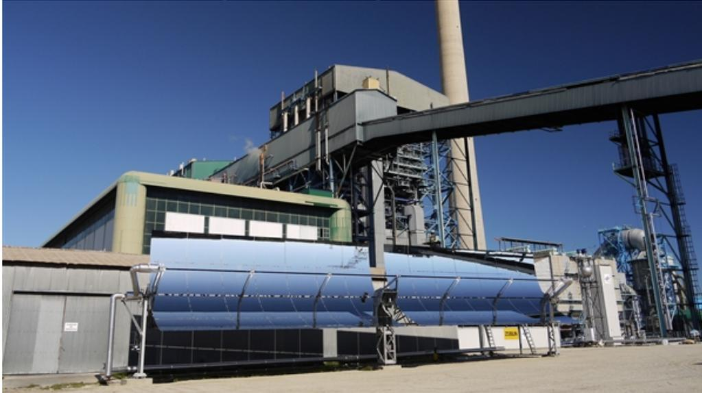
DLR und Endesa testen in dieser Anlage im spanischen Carboneras erstmals solare Direktverdampfung und Speicherung im Kraftwerksbetrieb. Bei diesem Solarkraftwerkstyp wird durch gebündelte Sonnenstrahlen der Wasserdampf, der später einen Stromgenerator antreibt, direkt erzeugt. Highlight der Anlage ist ein neuartiges Speichersystem, das die Wärme als fühlbare und als latente Wärme effizient speichert und damit die Stromproduktion eines Kraftwerkes auch bei Nacht möglich macht.
