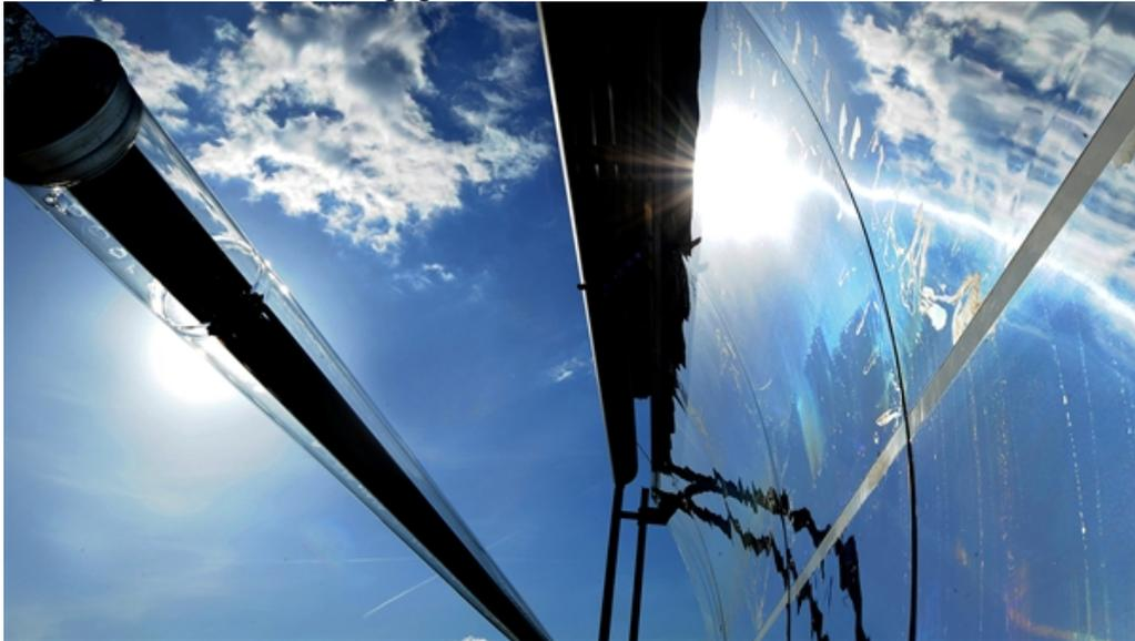
Bislang werden Thermoöle in Parabolrinnenkraftwerken eingesetzt. Thermoöl fließt in den Absorberrohren (dunkles Rohr links im Bild). Auf diese Absorberrohre konzentrieren die Parabolspiegel das Licht, hier wird die Sonnenstrahlung in Wärme umgewandelt mit der für einen konventionellen Kraftwerksprozess Dampf erzeugt wird. In der nun entwickelten Testanlage wird geschmolzenes Salz durch die Absorberrohre fließen.
