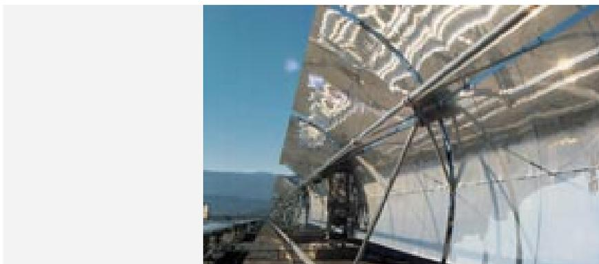
Parabolrinnenanlage auf der Plataforma Solar de Almería
