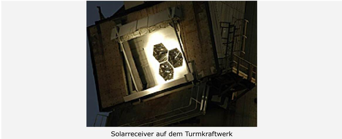
Solarreceiver auf dem Turmkraftwerk
