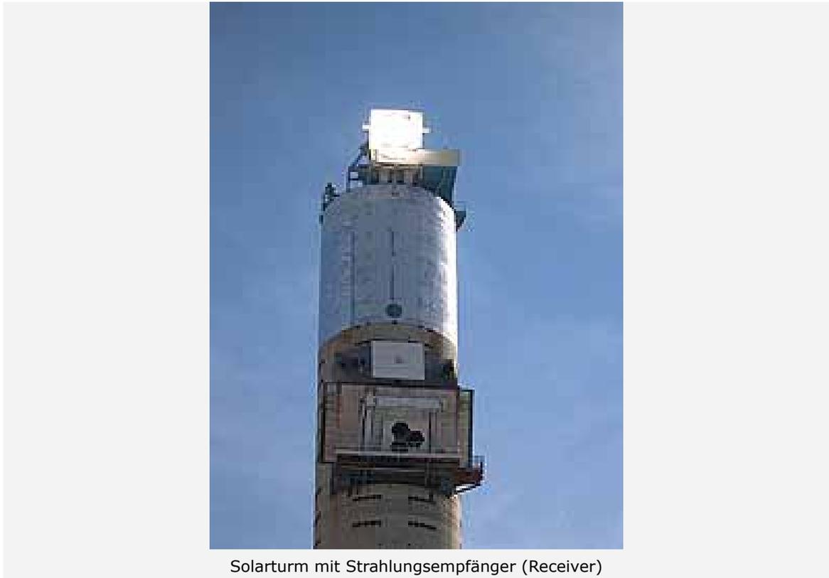
Solarturm mit Strahlungsempfänger (Receiver)
