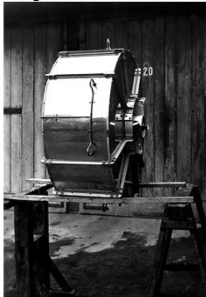
Demonstrator eines Düsentriebwerks: 1935 in Göttingen gebaut.
