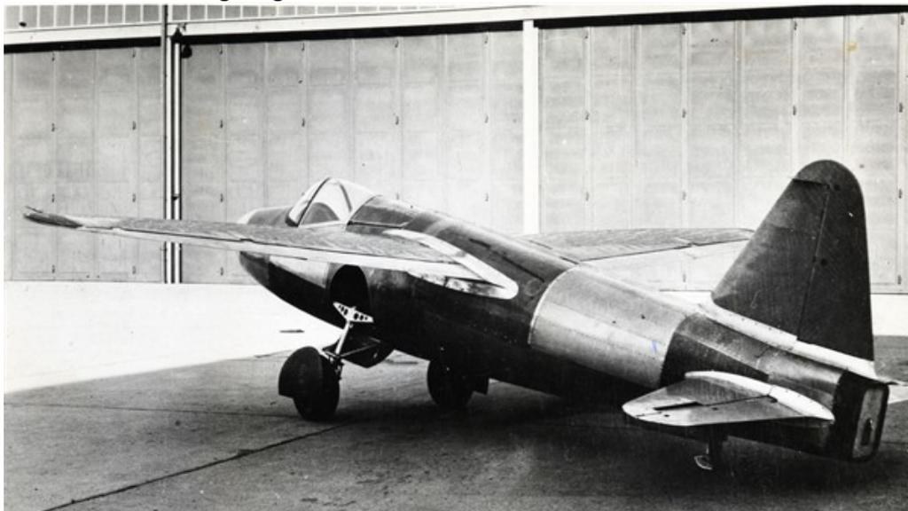
Das erste Düsenflugzeug der Welt: Die Heinkel 178 flog erstmals im August 1939 und läutete das Jetzeitalter ein. Die in der Maschine zum Einsatz gekommene Turbine basierte auf den Vorarbeiten, die Ohain in Göttingen geleistet hatte.
